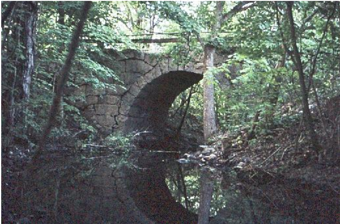
”Diket” vid stenvalvsbron år 1964
